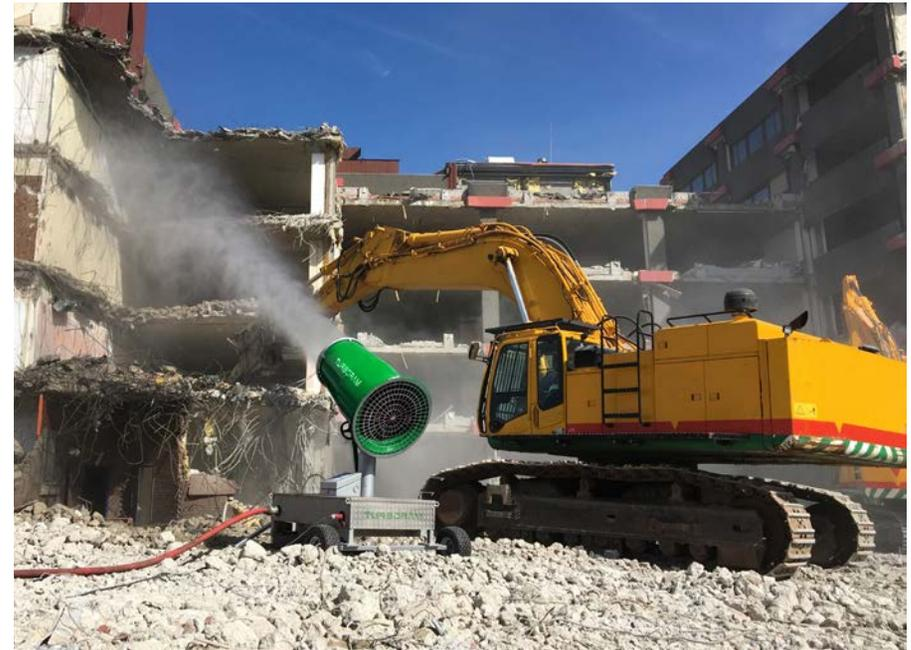
El cañón **TRD50** es el más compacto de los cañones Turbo RAM montados sobre plataformas. Está diseñado para el control de polución en áreas medianas y grandes. Es capaz de cubrir hasta 7.000 m<sup>2</sup> de superficie con su rotación de 320°. Su diseño compacto se ha diseñado para transportarlo con facilidad entre distintos puntos.
